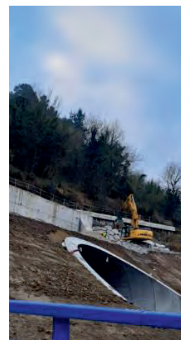
Ejecución muro escollera
