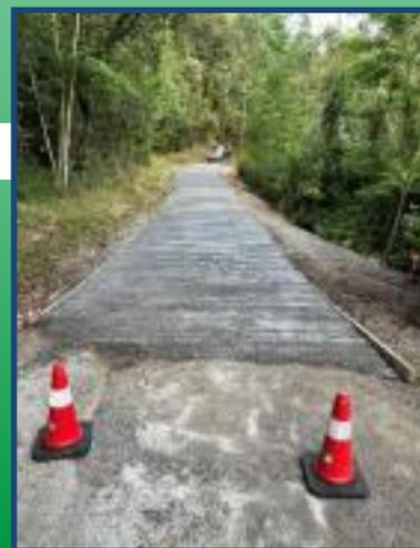
Además, se agregó un mallazo de 150x150x80 para reforzar aún más la estructura de la pista. Este mallazo, fabricado con barras de acero entrelazadas, aumenta la resistencia y la capacidad de carga de la superficie de hormigón.
